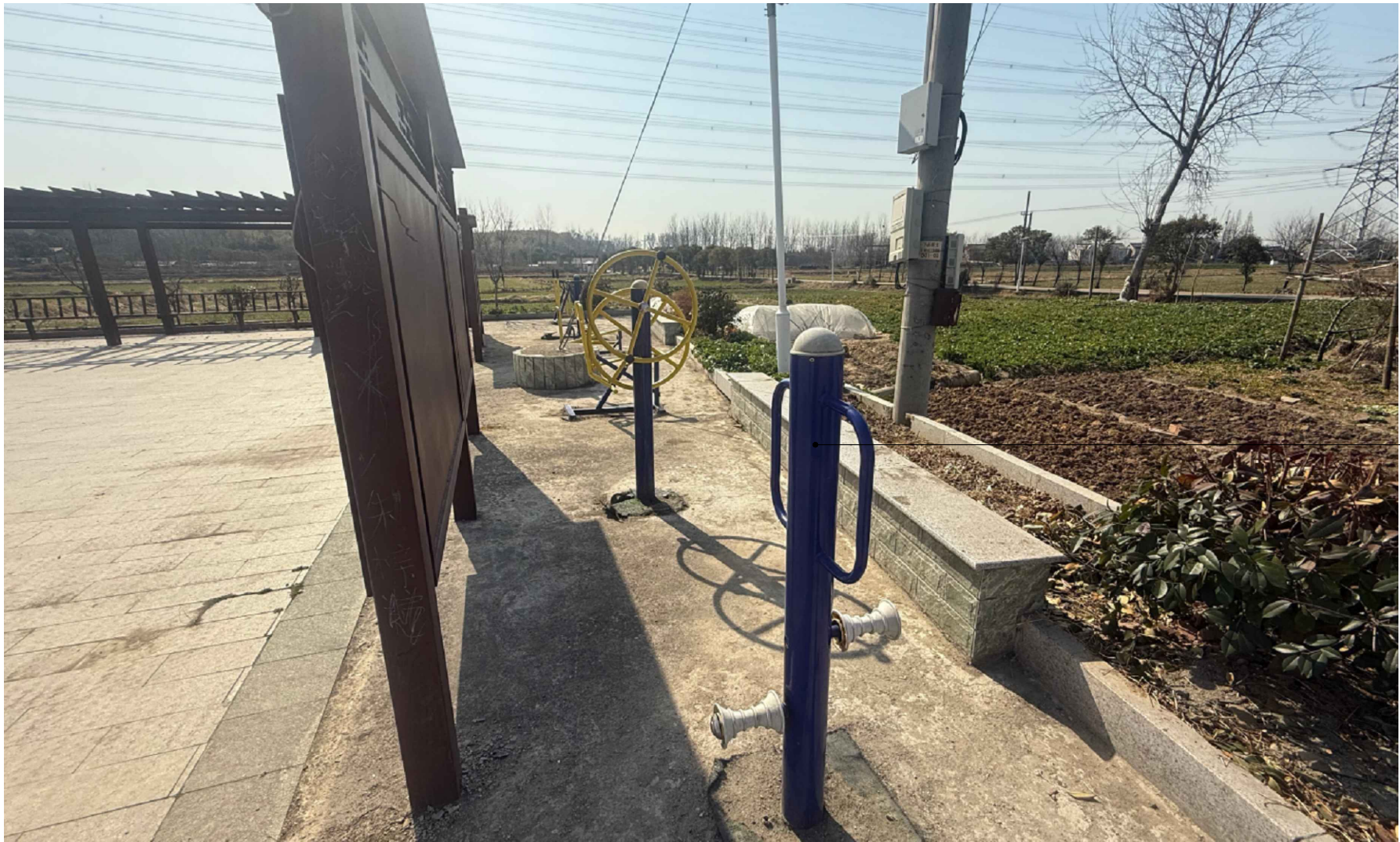
广场健身器材六件套面层出新, 刷器材原色漆
