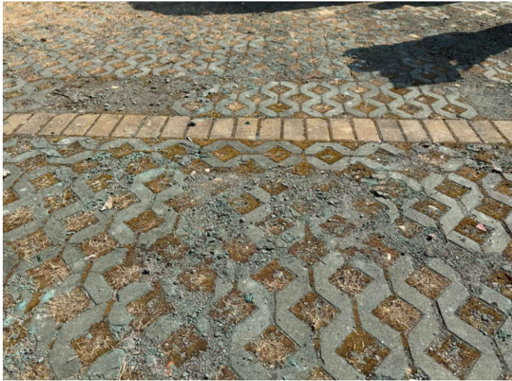
吴家楼组广场停车位10m 2 破损铺装更换 注：盖板材质样式及规格以现状铺装为准。
