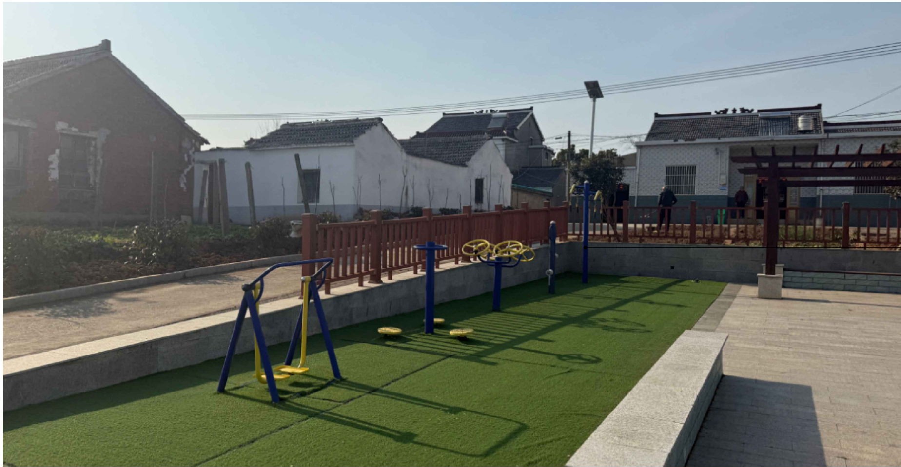
广场健身器材五件套面层出新, 刷器材原色漆
