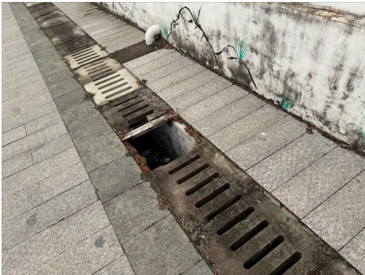
端营组广场2米破损盖板更换 盖板规格300*400*50
