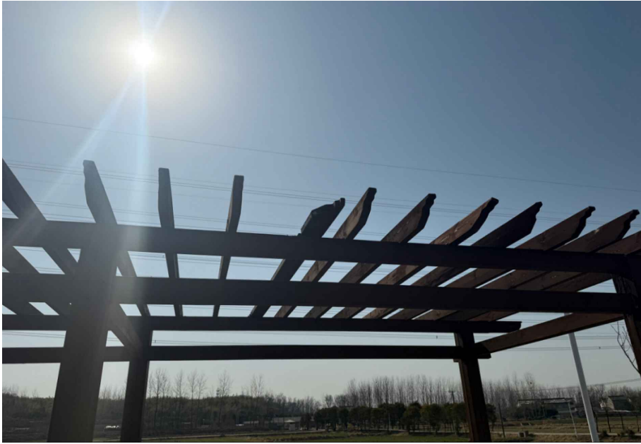
修复部分松动结构，重新安装。
