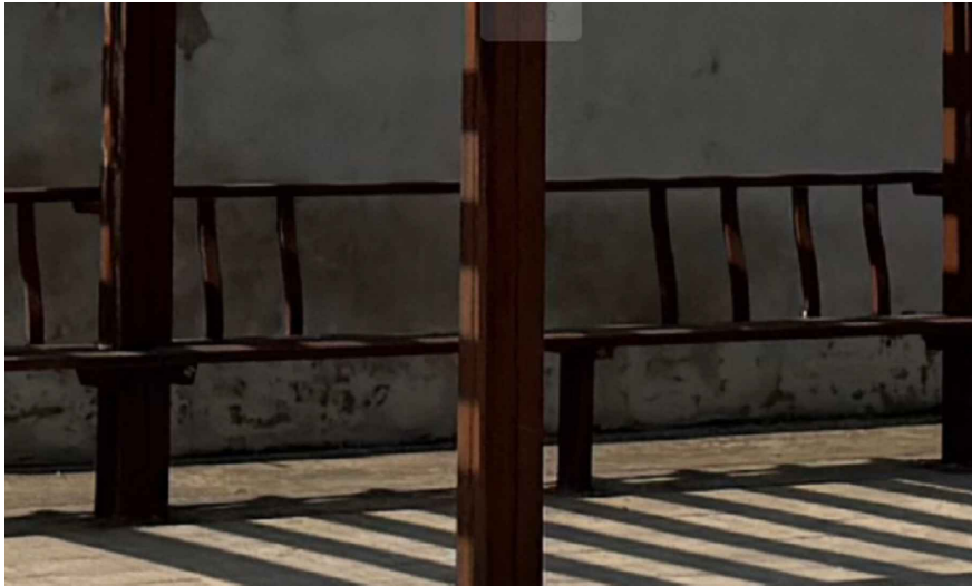
廊架美人靠缺失部件重新安装。
