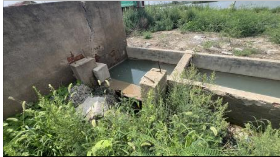
高庄村海水泵房维修加固现状图2
