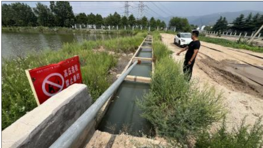
高庄村海水泵房维修加固现状图3
