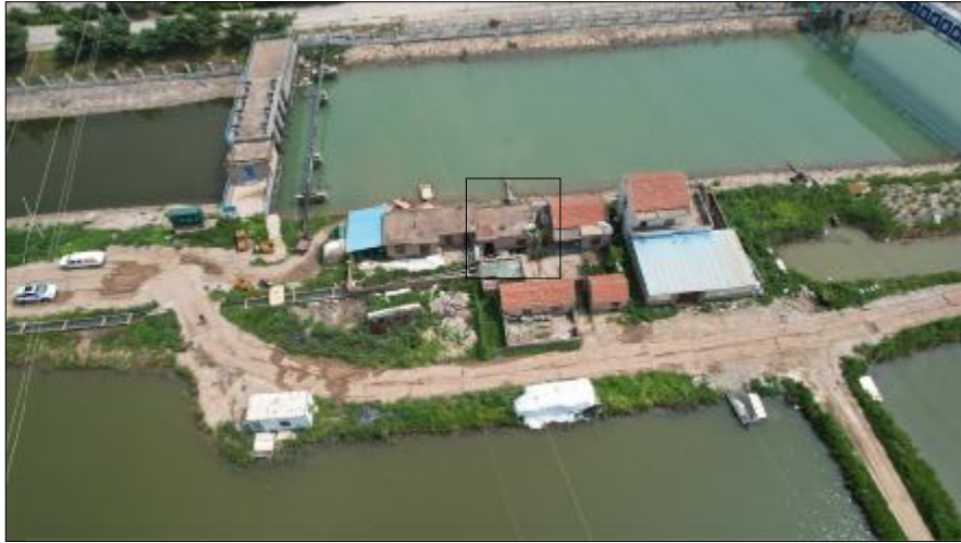
高庄村海水泵房维修加固现状图1
