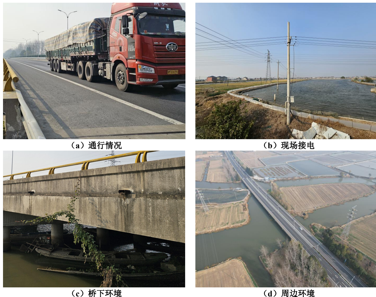
图 5.15-2 G344 肖家舍大桥现场调查情况
