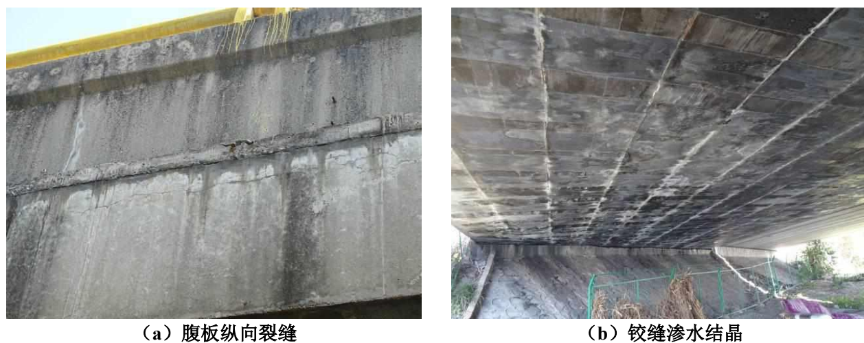
图 5.24-1 S231 卖水河桥 2023 年定期检查病害
