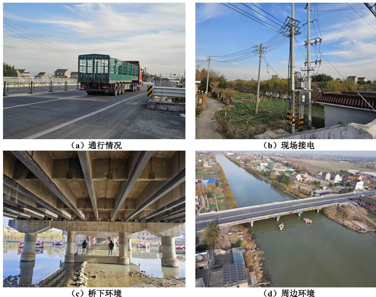
图 5.5-2 G345 马甸大桥现场调查情况
