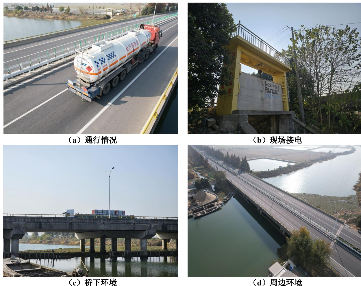
图 5.19-2 S231 大溪河大桥现场调查情况
