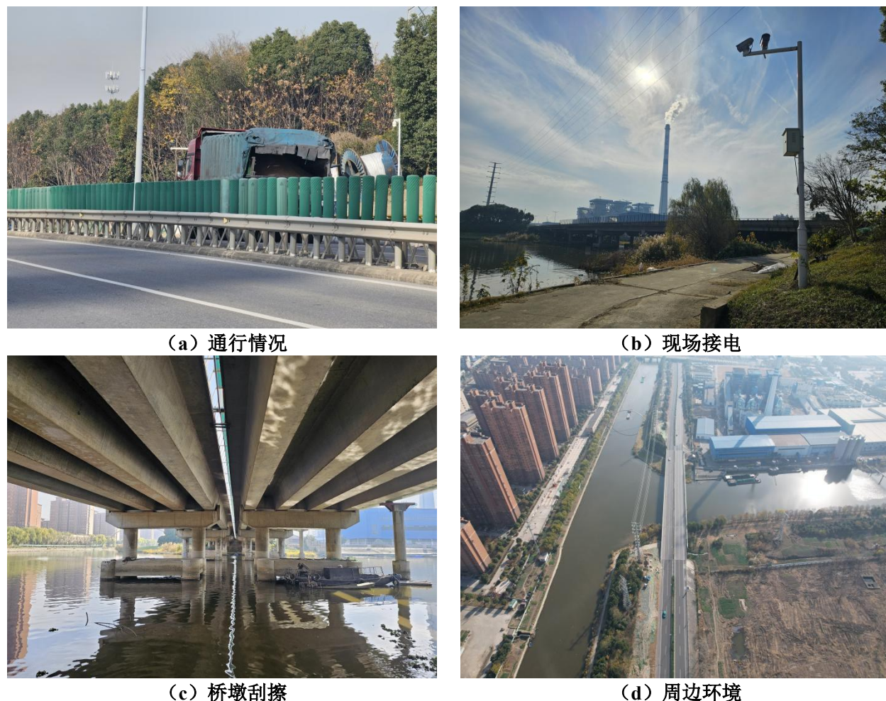
图 5.18-1 G523 送水河大桥现场调查情况
