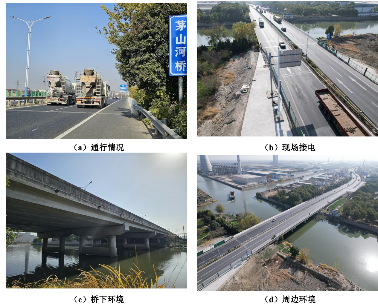
图 5.7-1 S229 茅山河桥现场调查情况
