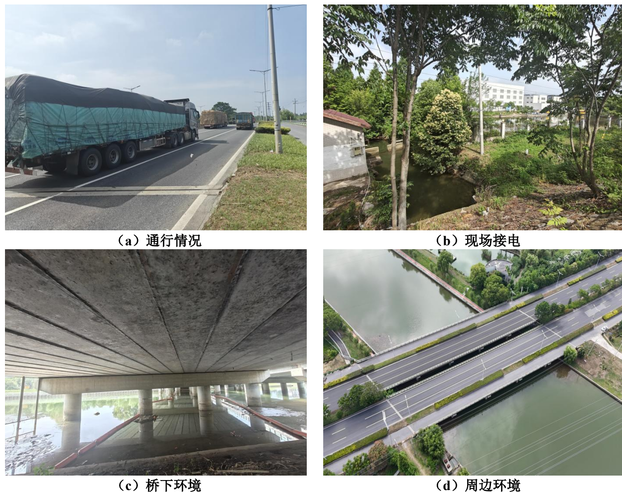
图 5.14-1 S506 送水河大桥现场调查情况
