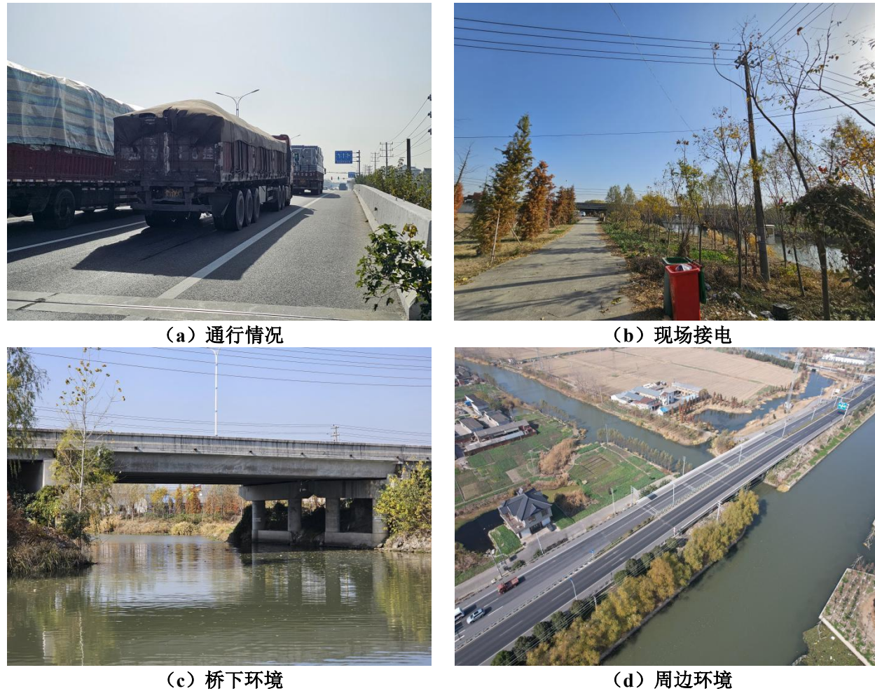
图 5.6-1 S229 史堡桥现场调查情况
