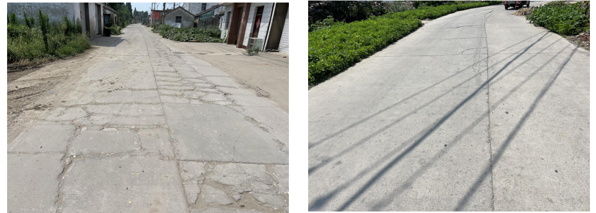
路面排水现状图
